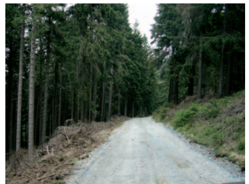
Forstwirtschaftsweg nach Instandsetzung
