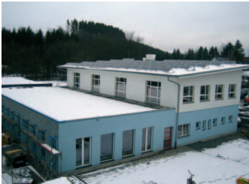
Neubau Mensa Schulzentrum Schmallingenberg
