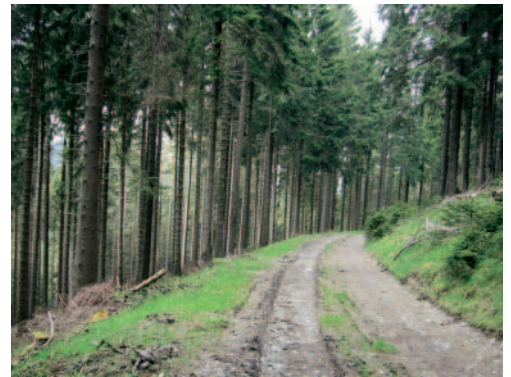
Forstwirtschaftsweg vor Instandsetzung
