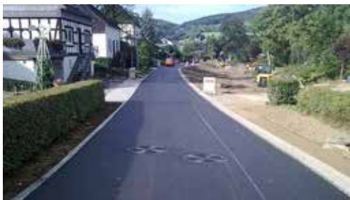
Straßenausbau „Im Siepen“ in Fleckenberg
