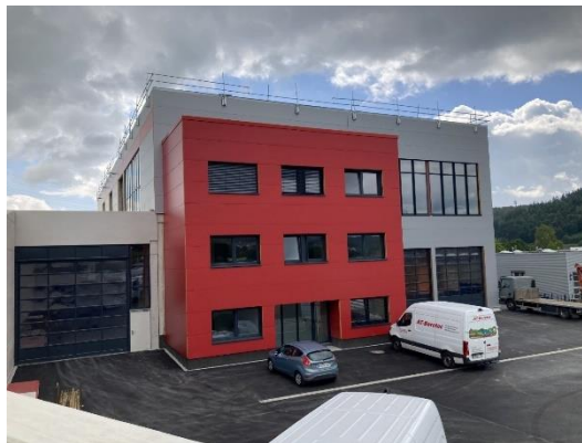
Abb. 8 Neues Gebäude im Plangebiet.
