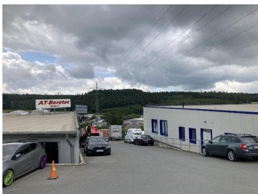
Abb. 9 Betriebsgelände der Firma AT Boretac.
