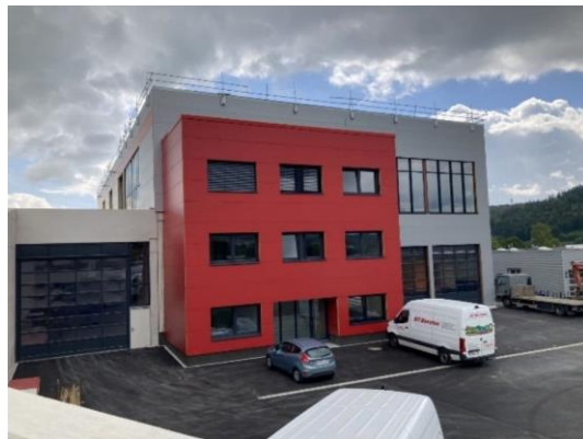
Abb. 12 Neues Gebäude im Plangebiet.
