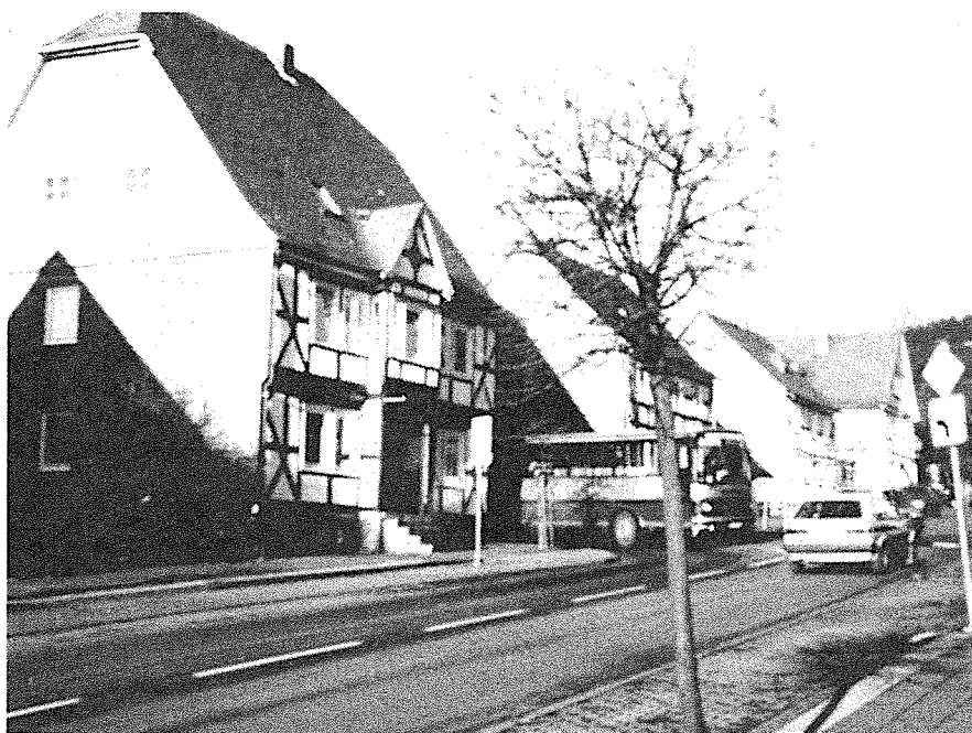
Die abknickende Vorfahrt der L 776 ist unübersichtlich und durch den Verkehr stark belastet
