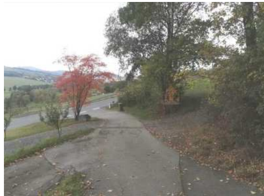
Abb. 11 Mündung des versiegelten Wirtschaftsweges auf die Kreisstraße K 17.
