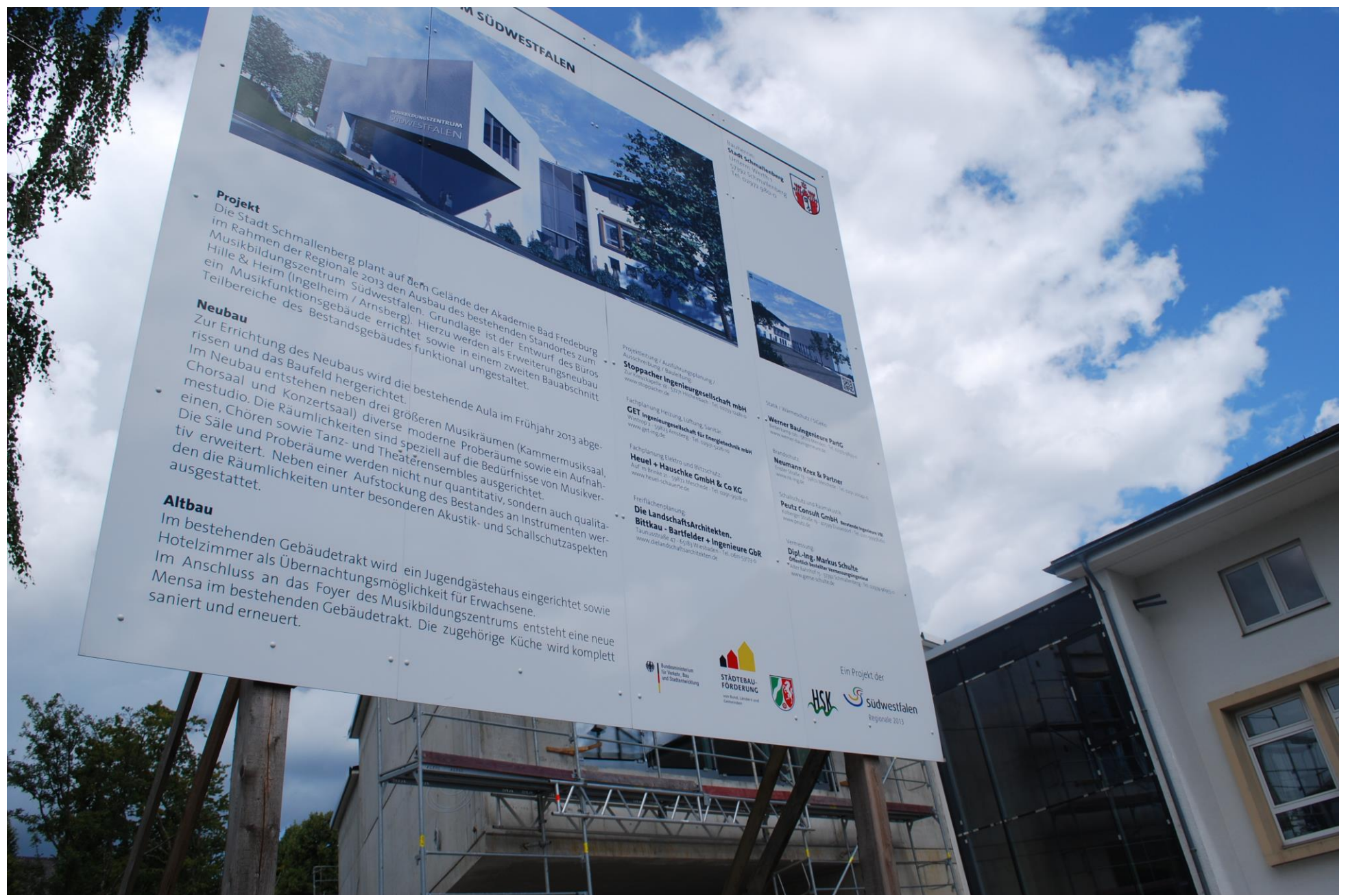
Schmallenberg 2030. REGIONALE-Projekt „Musikbildungszentrum Südwestfalen“ während der Bauphase
