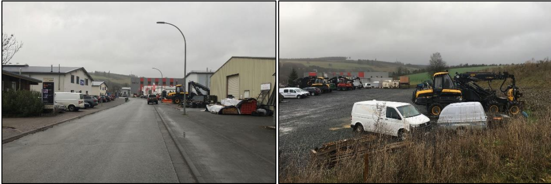
Abb. 11: links: Gewerbegebiet „Lake“ (Blickrichtung Süden), rechts: Lagerfläche am Beginn des Wirtschaftswegs (Blickrichtung Norden)
