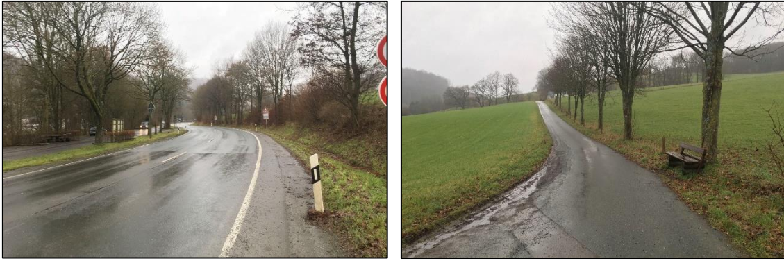
Abb. 8: links: B 511 (Blickrichtung Westen), rechts: Zuwegung Haus-Nr. 19/20, Ahorn-Baumreihe (Blickrichtung Nordosten)
