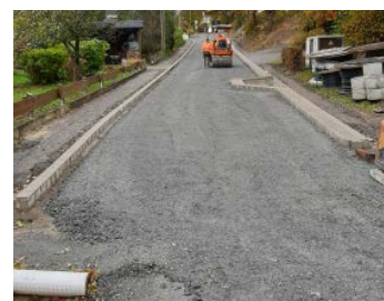
Erneuerung der Ringstraße in Bracht
