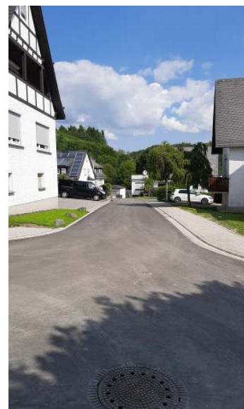
Ausbau der Straße Zur Rehmecke in Bödefeld
