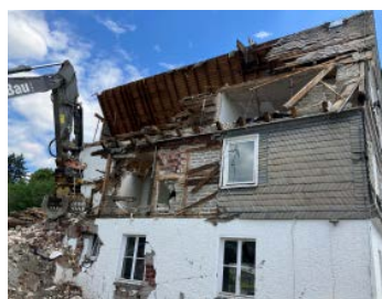
Abbruch und Neubau des Gebäudes Am Kurhaus 7 in Bad Fredeburg
