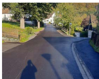
Erneuerung der Ortsdurchfahrt Oberrarbach
