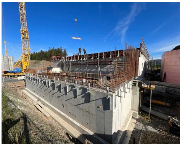
Neubau des Hochbehälters Robbecke in Schmallenberg
