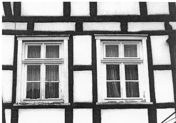
Fensteröffnungen entsprechen dem Maß des Fachwerks, oder sie bringen die Gebäudegliederung aus dem Gleichgewicht.
