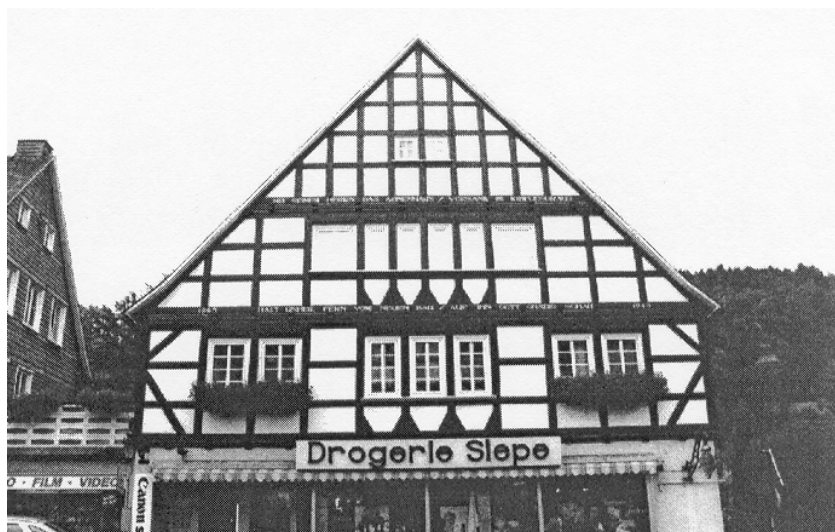
Ein regelmäßiger Rhythmus der Gefache ist für die Fredeburger Fachwerkbauten nach 1810 typisch.
