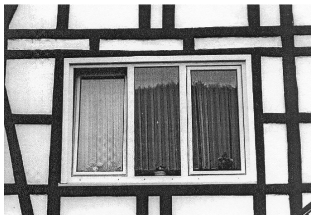
Fensteröffnungen entsprechen dem Maß des Fachwerks, oder sie bringen die Gebäudegliederung aus dem Gleichgewicht.
