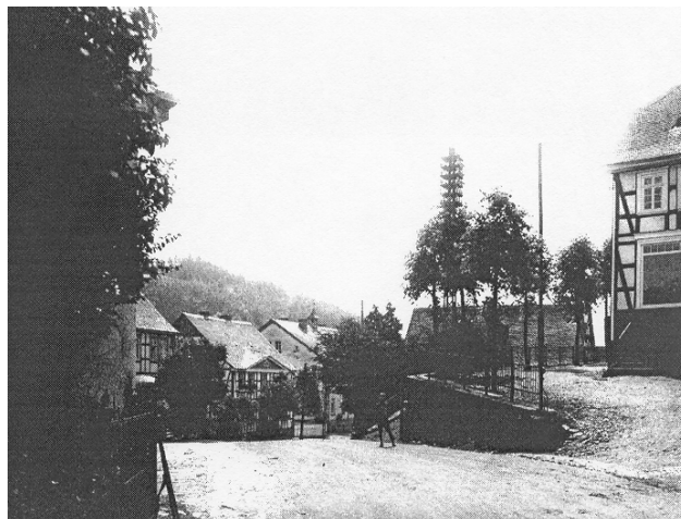
Stützmauern und unbefestigte Straßen kennzeichneten um 1928 das Bild am Burgberg.
