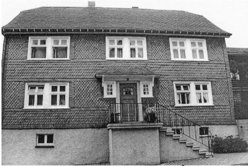
Historisch überschritt das Verhältnis von Öffnungen zu Wand nicht das Maß von 1/3
